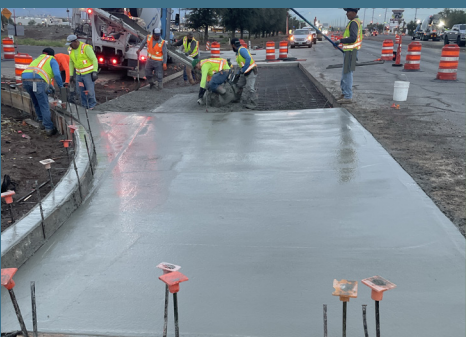
Instalación de entradas para vehículos cerca de Sunset Rd y Boulder Hwy
