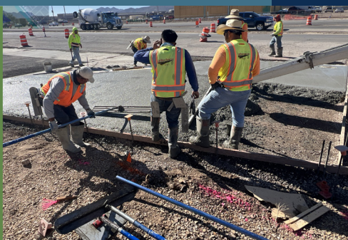
Instalación de aceras cerca de Warm Springs Rd y Boulder Hwy
