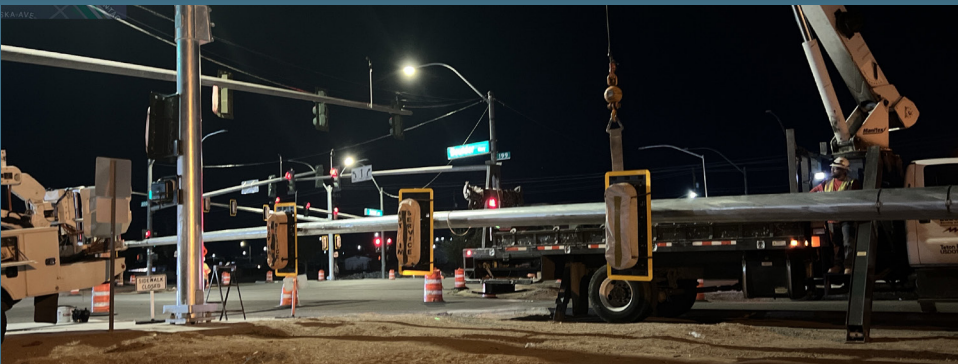
Instalación de semáforos en Texas Ave y Boulder Hwy
