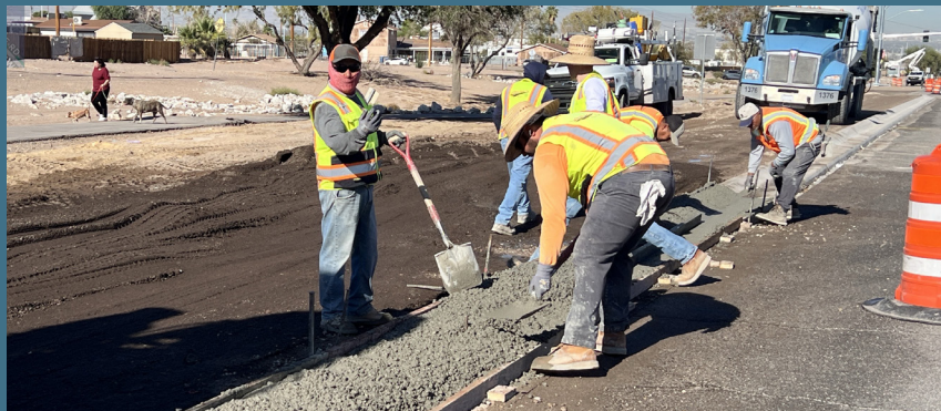
Instalación de nuevos bordillos
