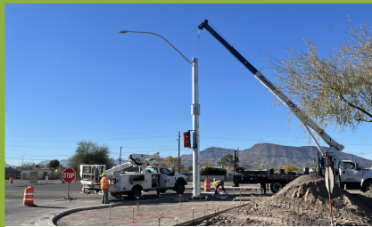
Equipos colocando una farola en el nuevo acceso a Pioneer Rd
