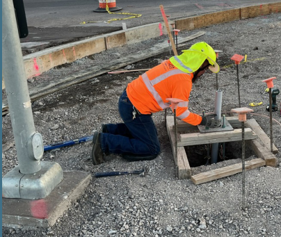
Instalación de cimientos para el botón de cruce de peatones cerca de Water St
