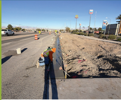
Instalación de bordillo cerca de Lake Mead Pkwy
