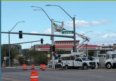
Instalación de alumbrado público en Galleria Dr
