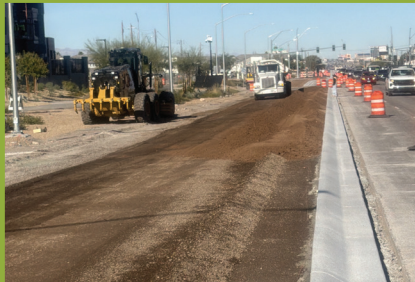
Nivelación de la futura ciclovía cerca de Gibson Rd
