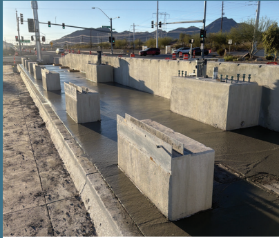
Trabajos de hormigón para la futura parada de autobús en Magic Way
