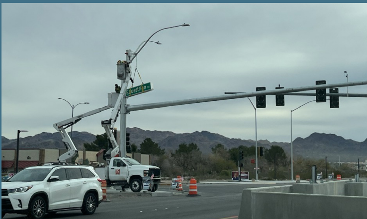
Equestrian Dr después: Se desmonta la señal antigua y se reemplaza la señalización
